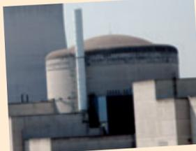
Par une batterie de compresseurs placés à l'extérieur, le Bâtiment Réacteur (BR) est soumis à une pression de 4,2 bars. On vérifie ainsi son étanchéité.
